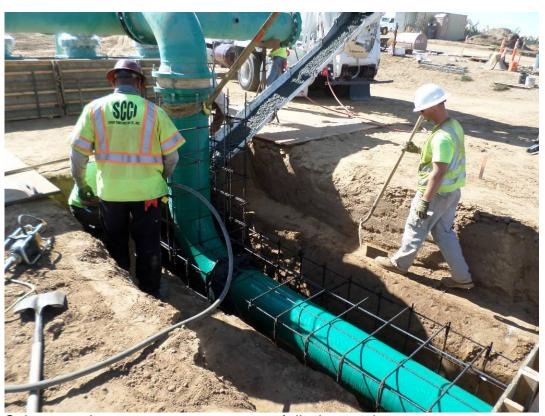
Spiess pouring concrete encasement of discharge pipe.
