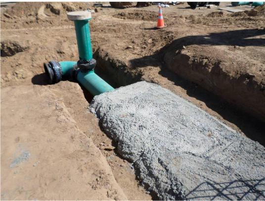
Discharge pipe encasement poured.
