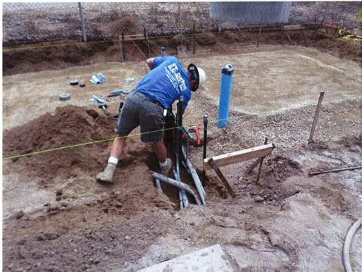
Spiess installing underslab conduit.
