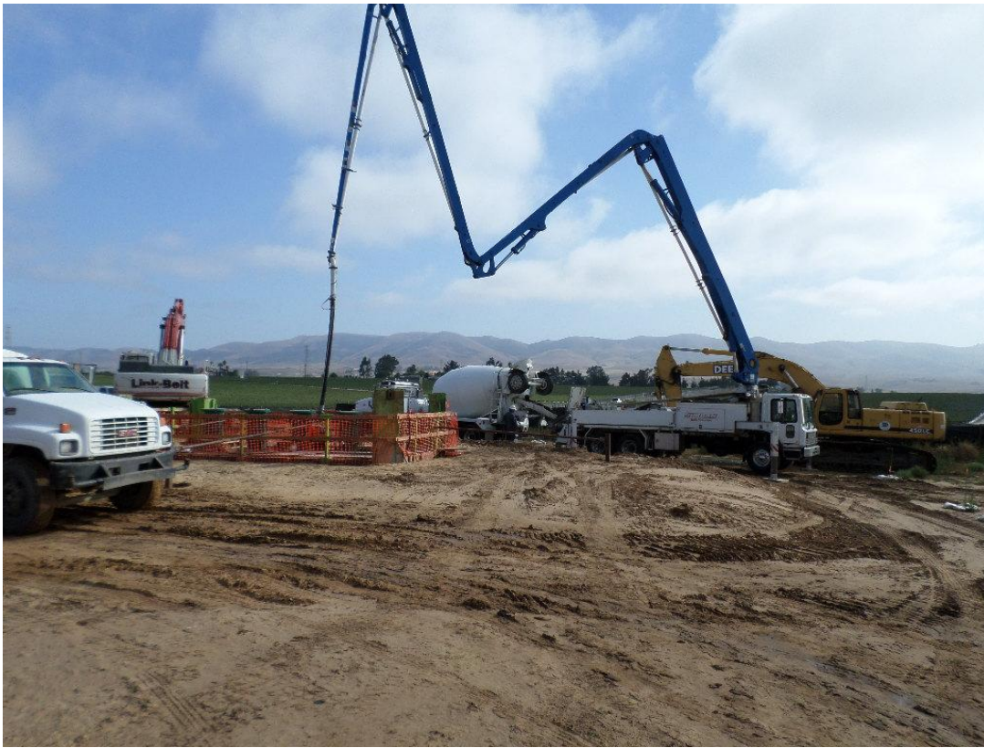
Spiess pouring pump can encasements.
