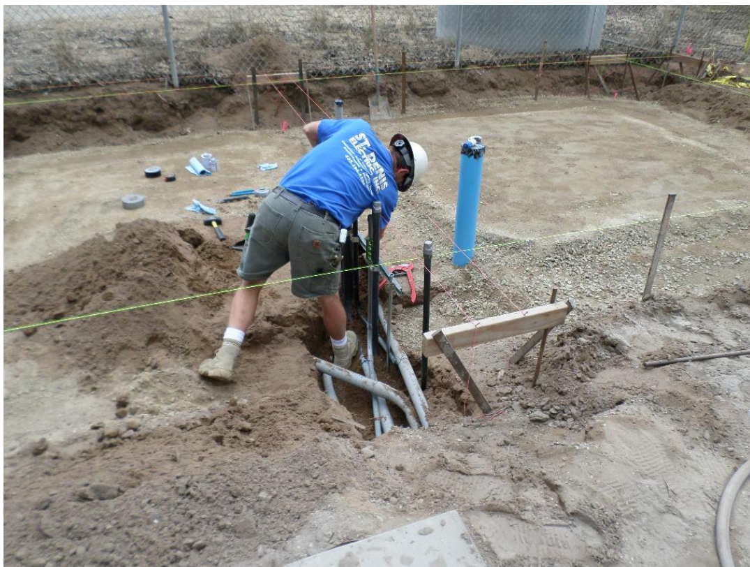
Spiess installing underslab conduit.
