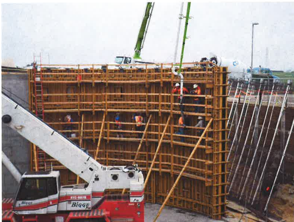
Second wall pour.
