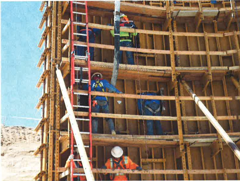
First wall pour.
