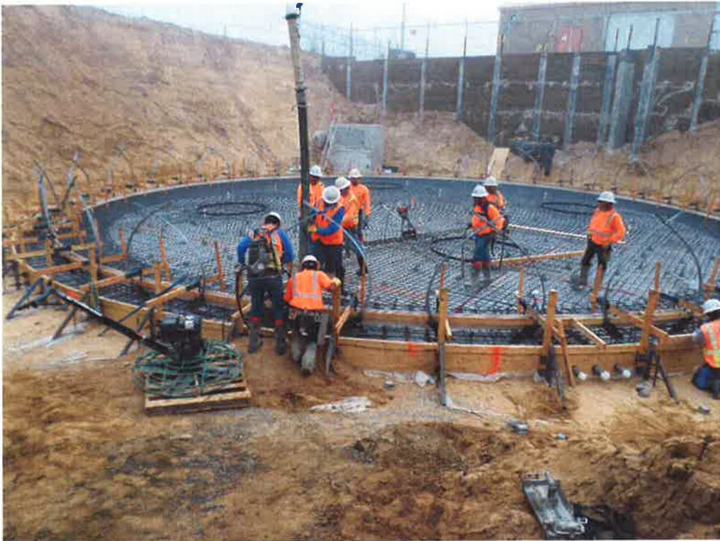
PHC starting concrete pour of tank slab.
