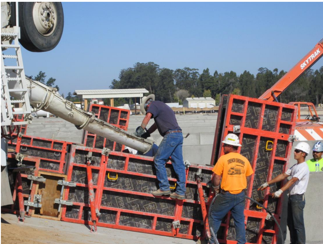
Final wall pour at the Sludge Drying Beds.
