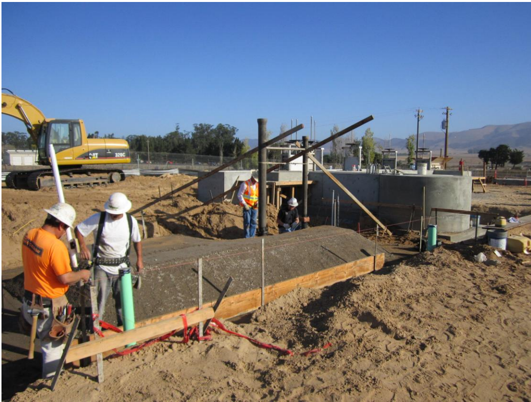
Cushman preparing for pour of Grit Classifier slab.
