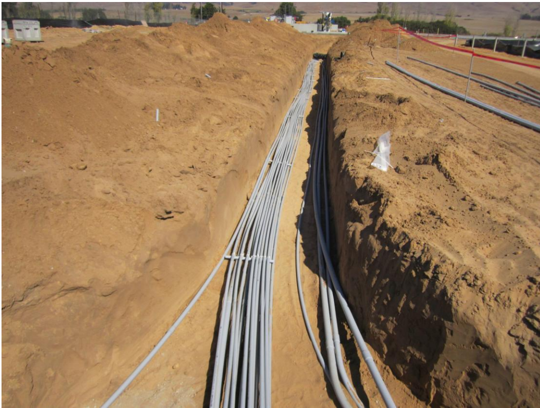
Bergelectric installing conduit for DB 02.
