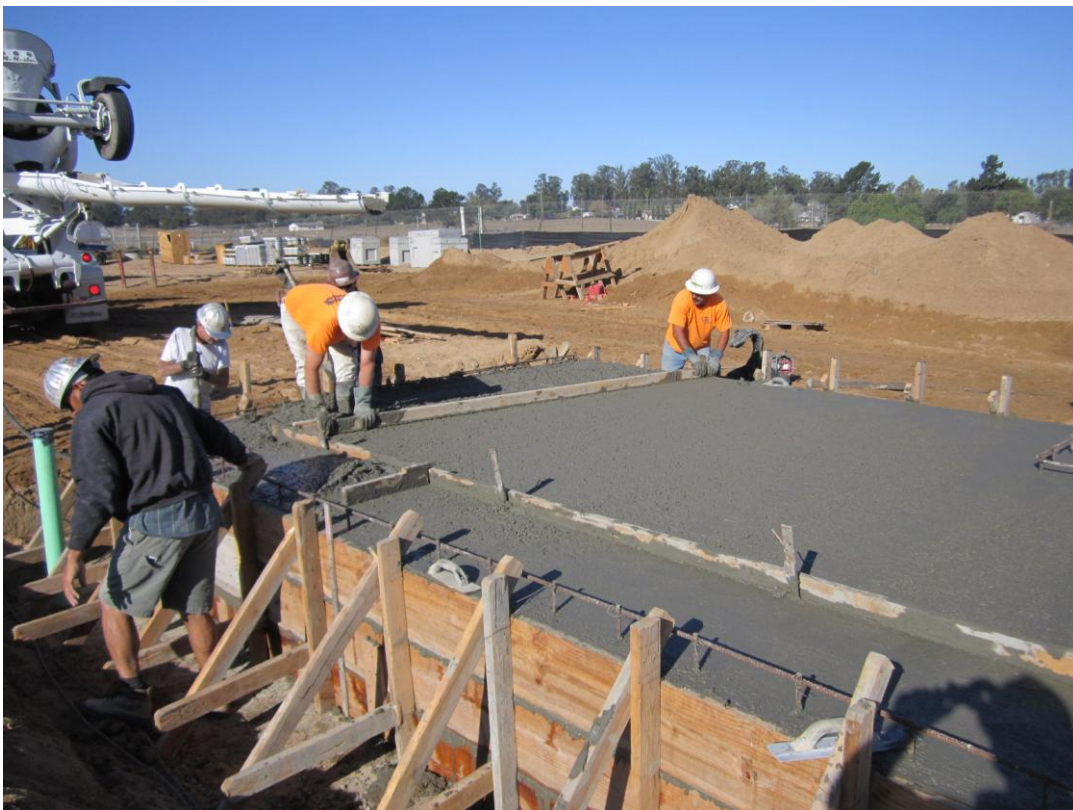
Cushman pouring the Grit Classifier slab.
