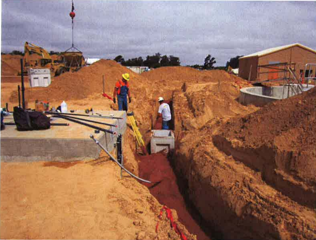
Bergelectric pouring red slurry over DB-24.
