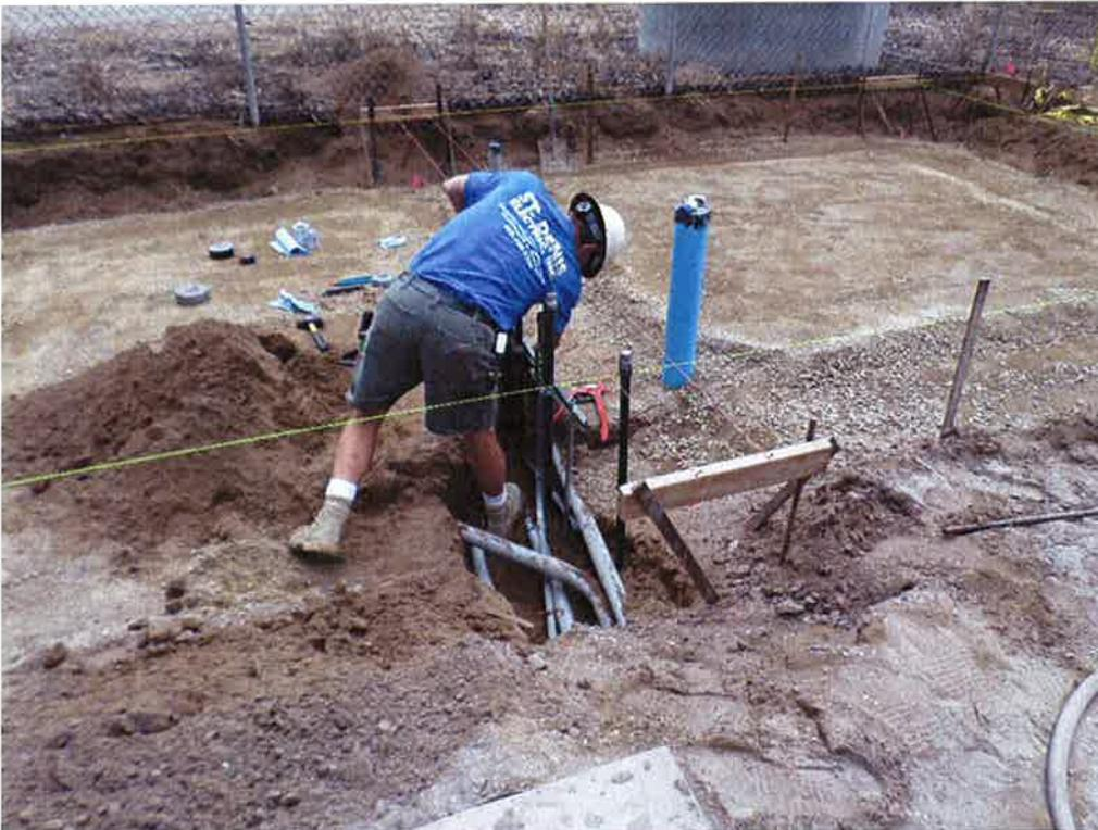
Spiess installing underslab conduit.
