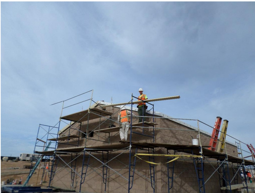
Spiess installing fascia.
