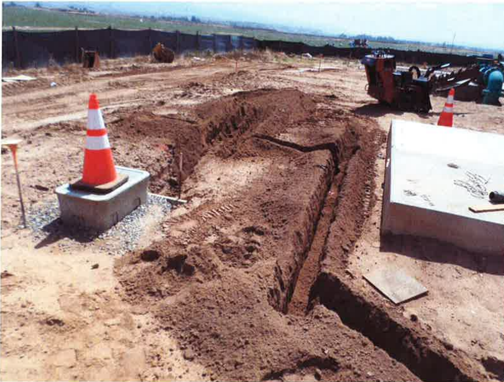
A.H. Ratterree installing landscape conduit.
