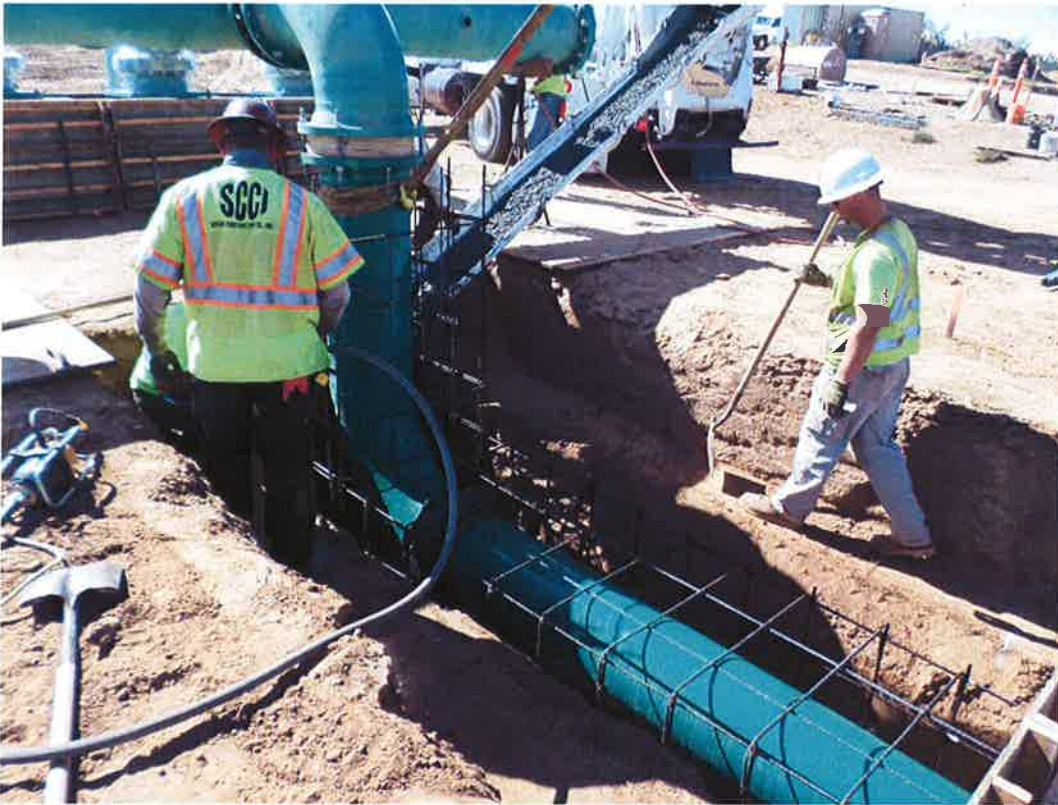
Spieß pouring concrete encasement of discharge pipe.
