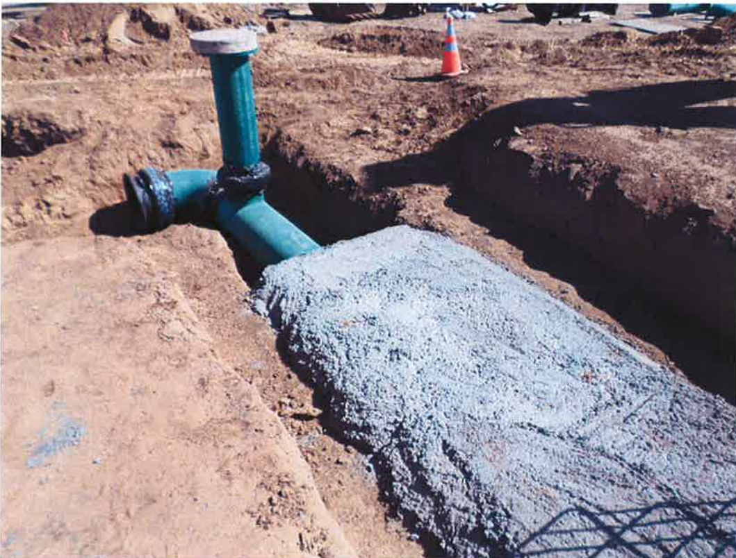
Discharge pipe encasement poured.
