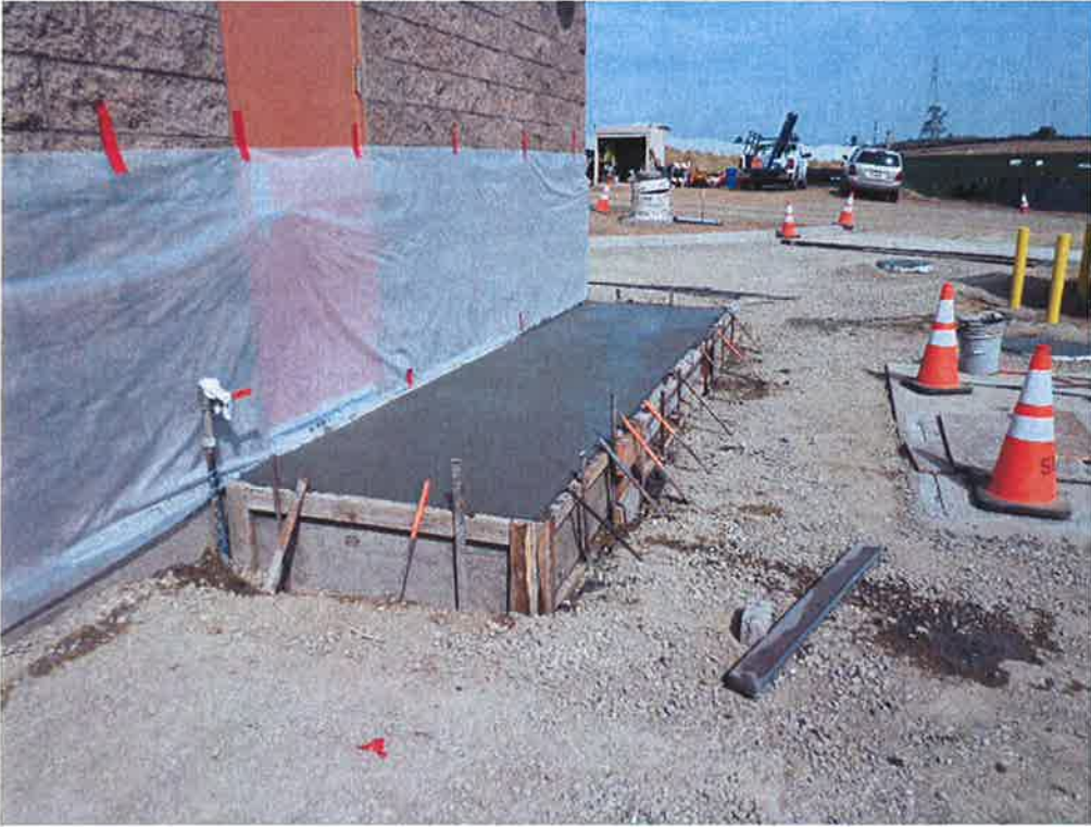
Sidewalk pour completed.
