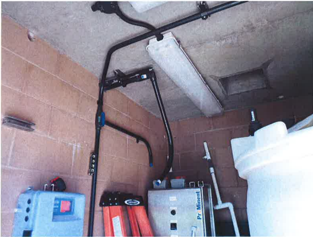
Spiess installing conduit.
