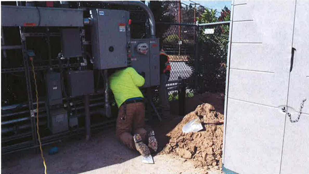
St. Denis Electric installing conduit.
