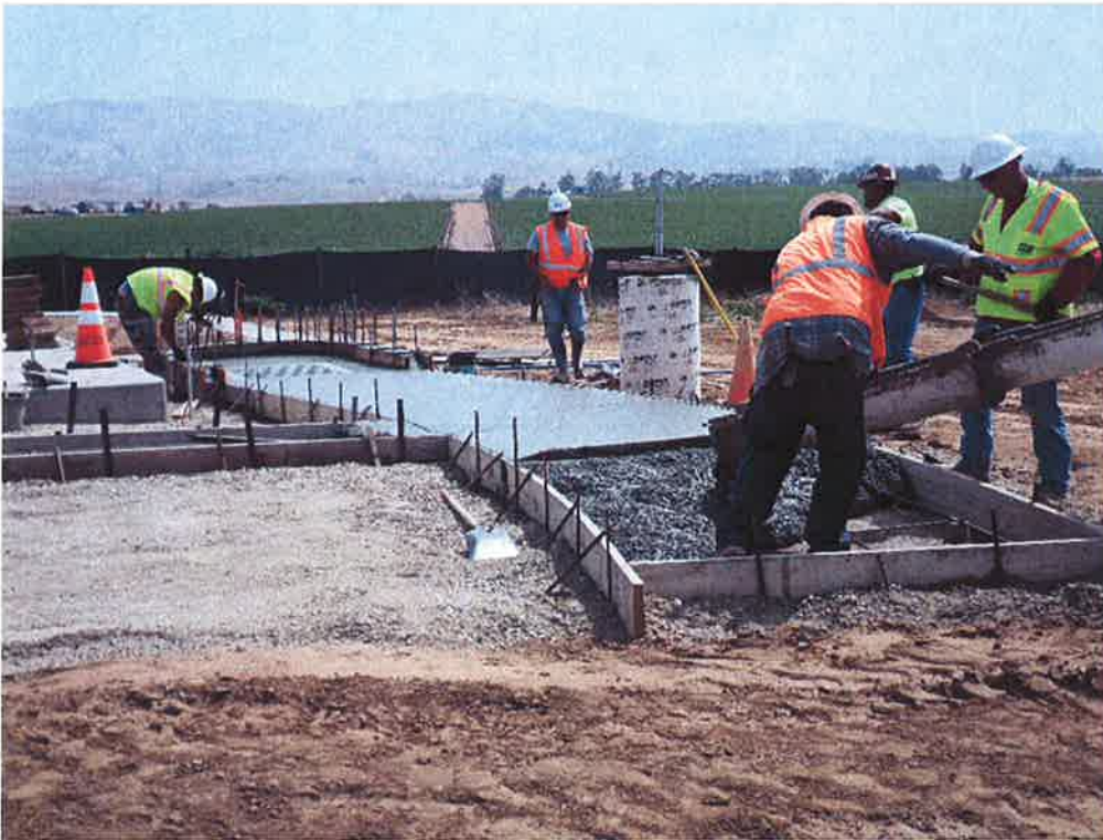
Spies pouring six foot V-ditch.
