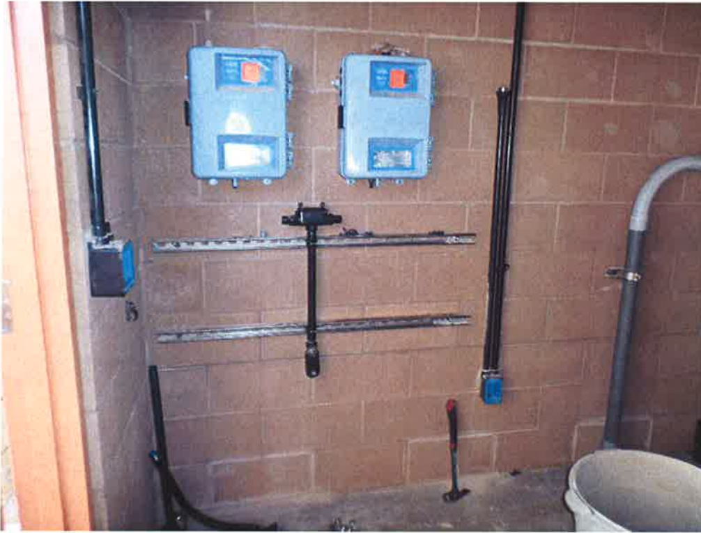
St. Denis installing conduit at Eureka.
