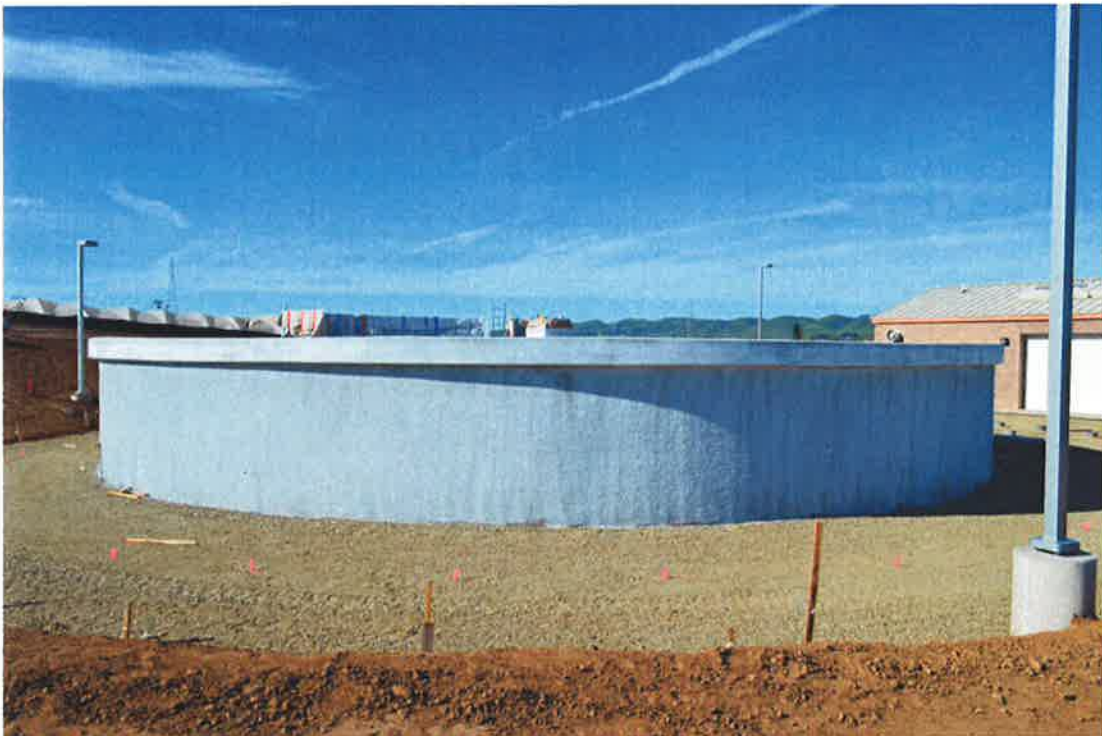
Primer on reservoir.
