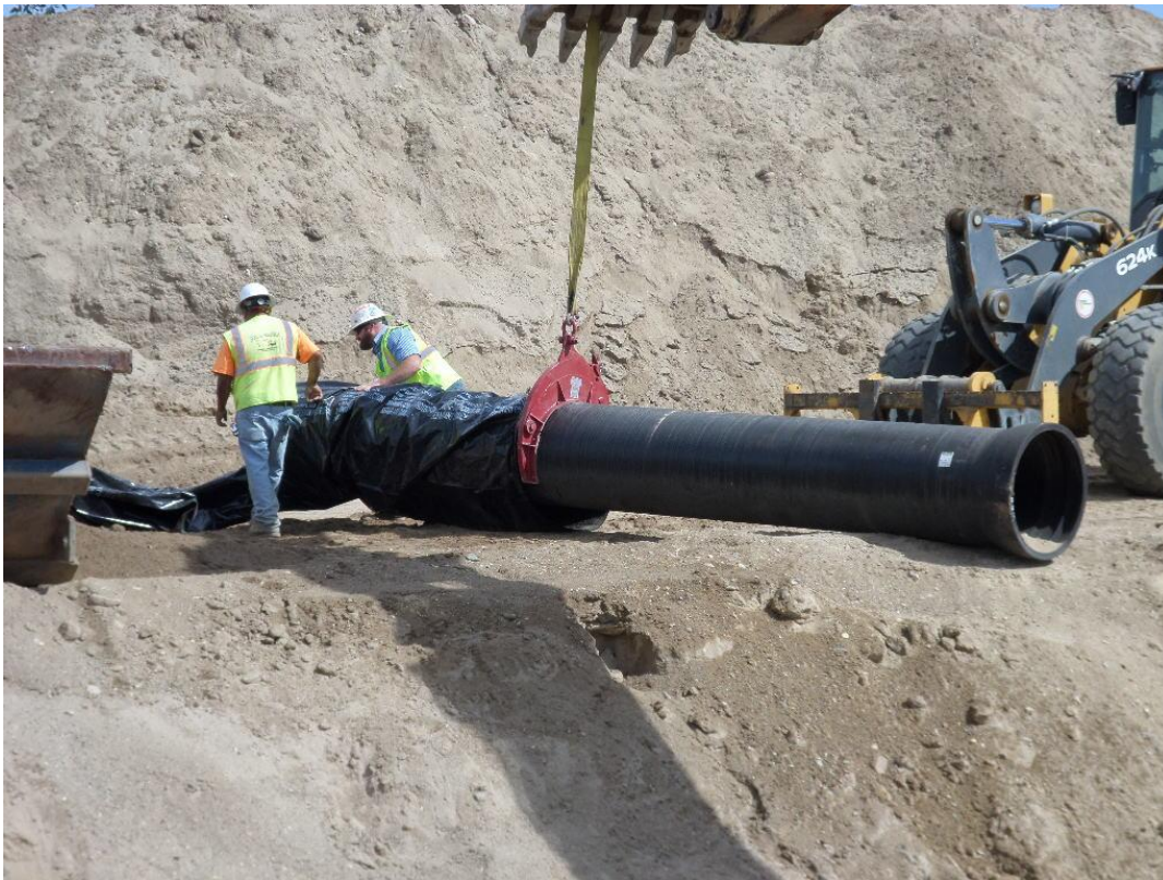
D-KAL pulling plastic wrap over DI pipe.
