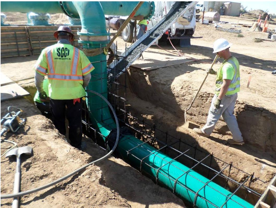
Spieß pouring concrete encasement of discharge pipe.
