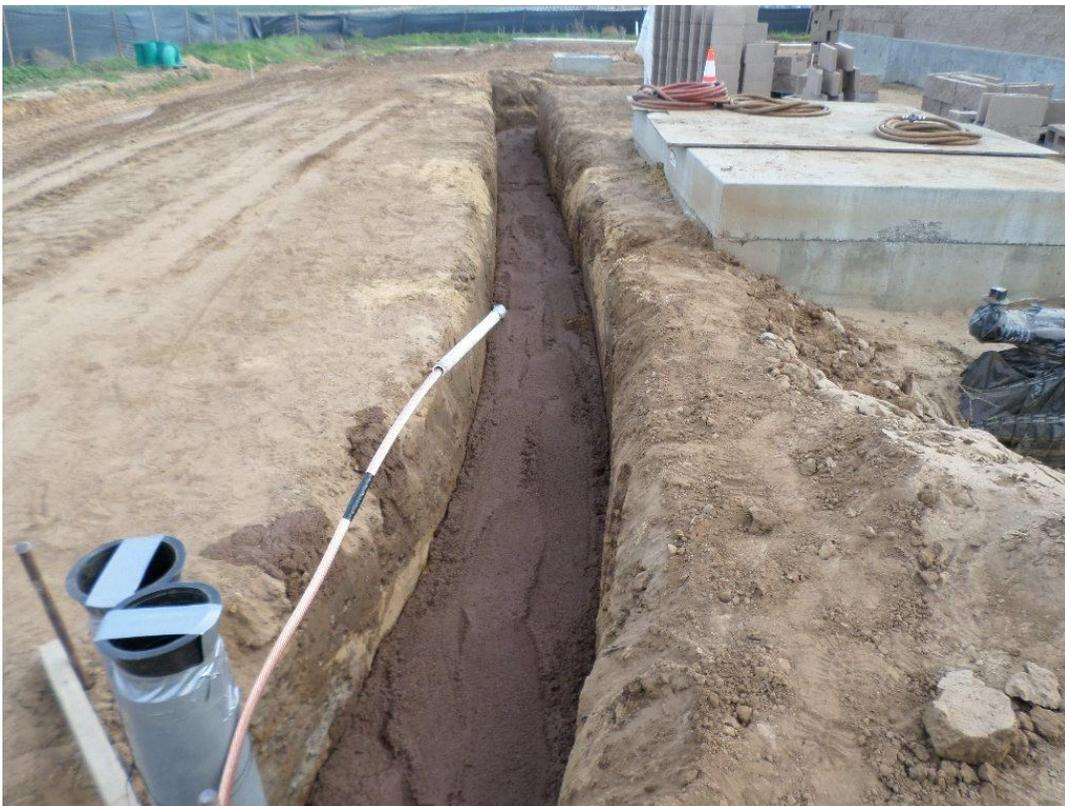
Red slurry over site electrical conduit.
