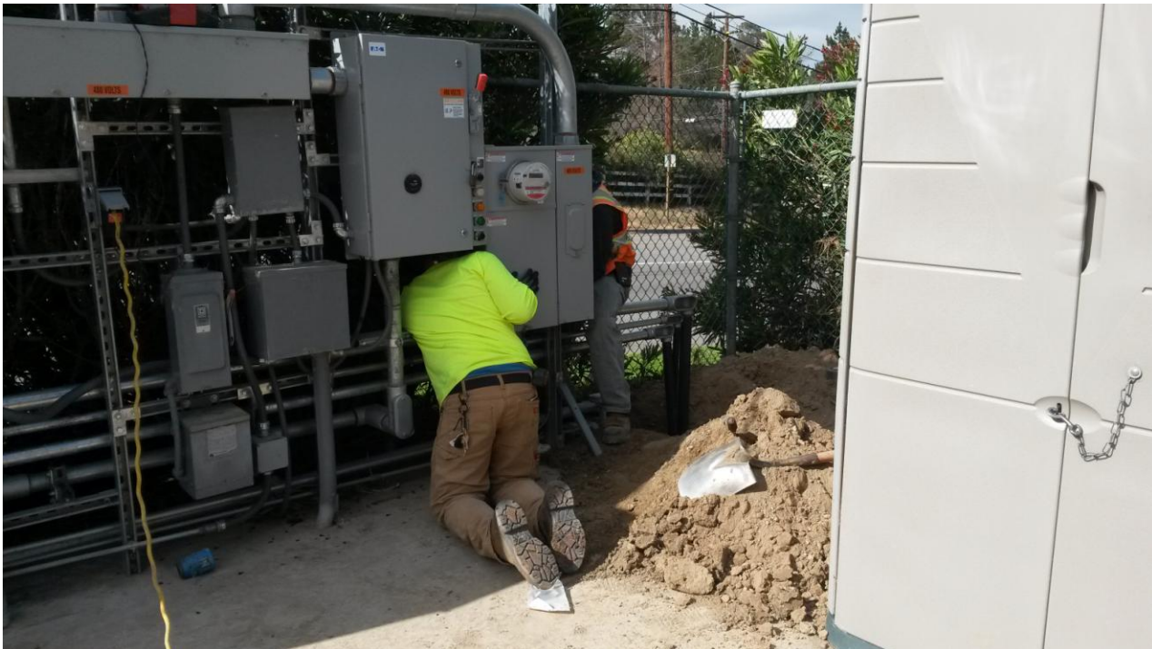
St. Denis Electric installing conduit.
