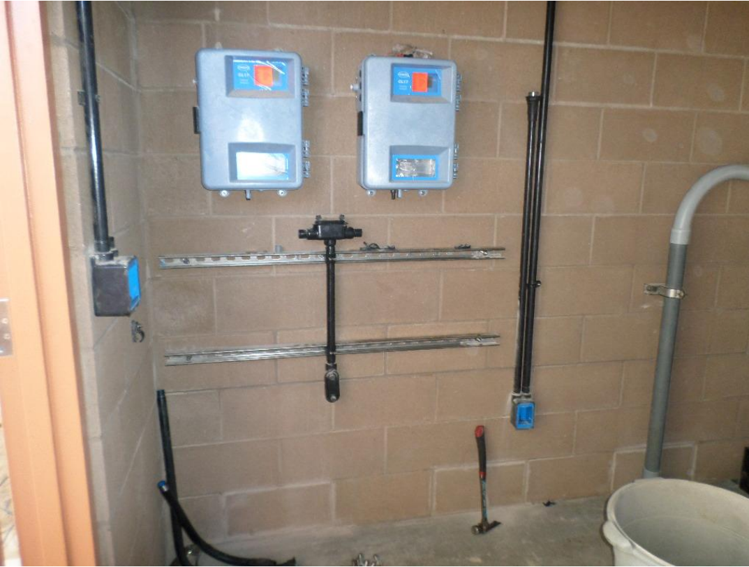
St. Denis installing conduit at Eureka.
