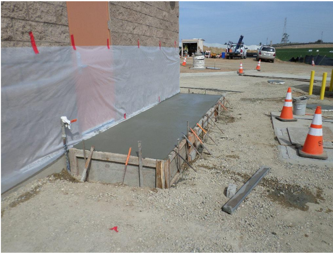
Sidewalk pour completed.
