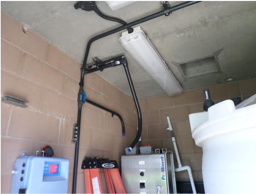
Spieß installing conduit.
