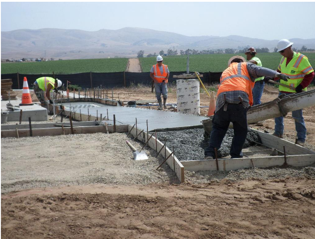
Spieß pouring six foot V-ditch.
