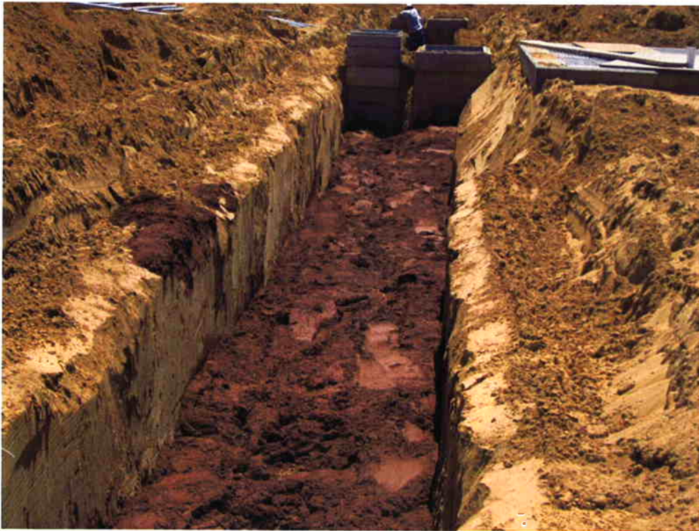
Bergelectric pouring red slurry over electrical conduit Duct Banks #16 & 22.
